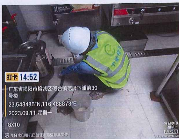
施工 3 标 GX10 厨房生活污水
