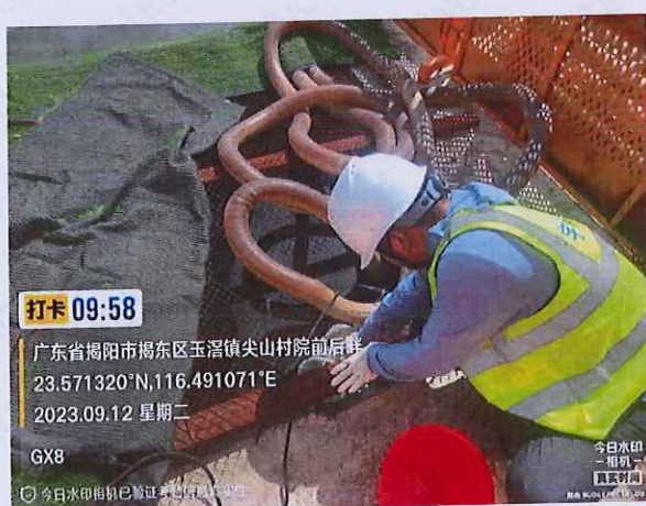
施工 2 标 GX8 生产废水
