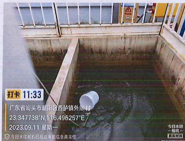
CYB09 顶管井生产废水
