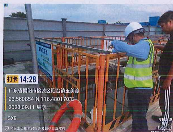
施工 3 标 GX9 生产废水
