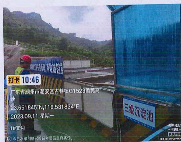
施工 1 标 1#支洞隧道洞口排水
