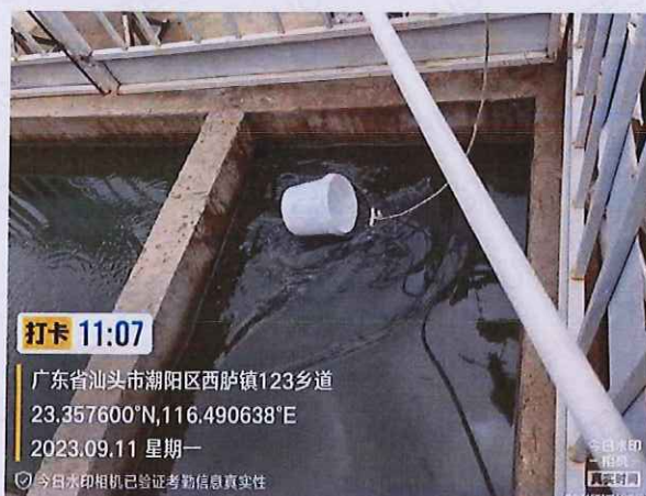
CYB08 顶管井生产废水
