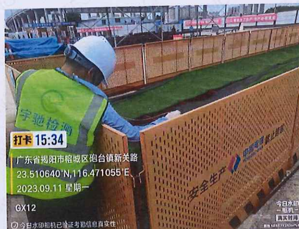
施工 2 标 GX12 生产废水
