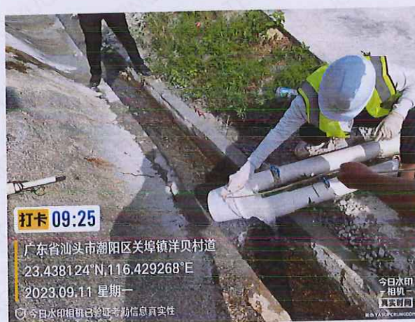
TBM 隧道洞口排水
