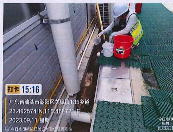
施工 4 标 GX13 厨房生活污水
