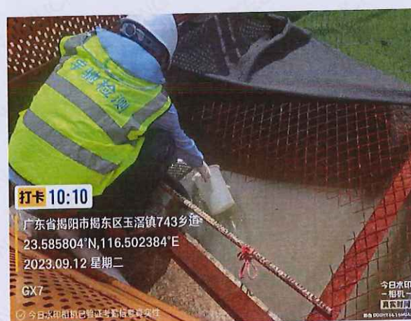
施工 2 标 GX7 生产废水
