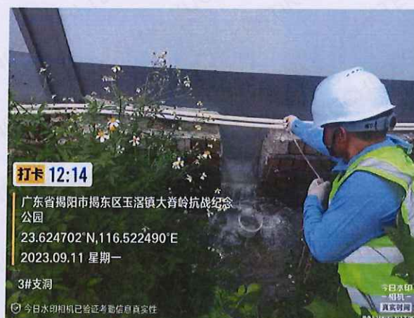
施工 1 标 3#支洞隧道洞口排水
