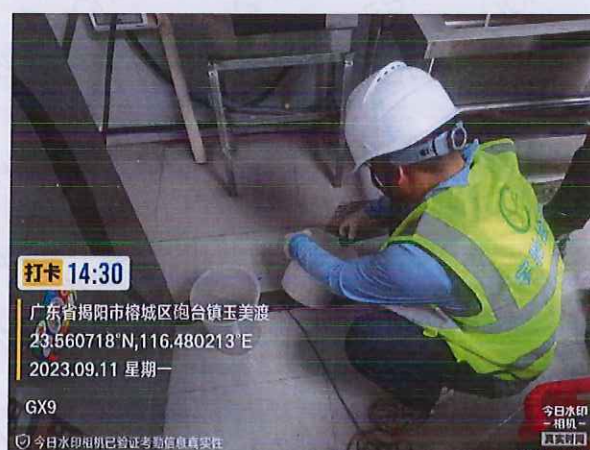
施工 3 标 GX9 厨房生活污水
