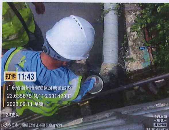
施工 1 标 2#支洞隧道洞口排水
