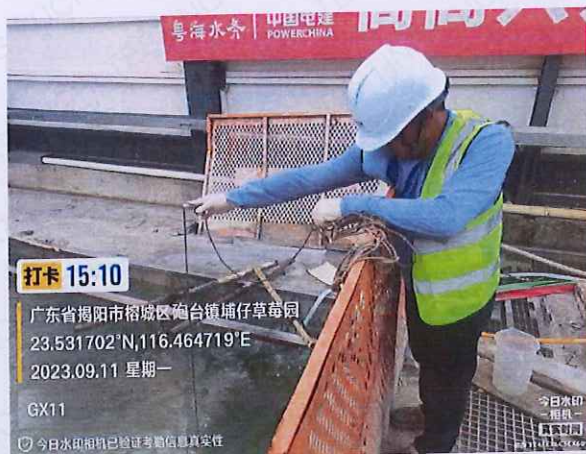
施工 2 标 GX11 生产废水
